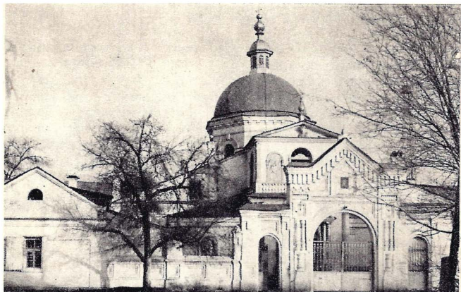
Церковь Иоанна Златоуста в Астрахани. 1763
